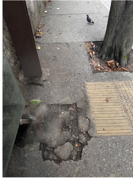
Imagem 15 - Calçada remendada junto a ponto de ônibus
