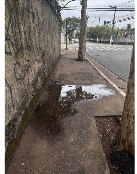
Imagem 16 - Empoçamento de água em trecho de concreto
