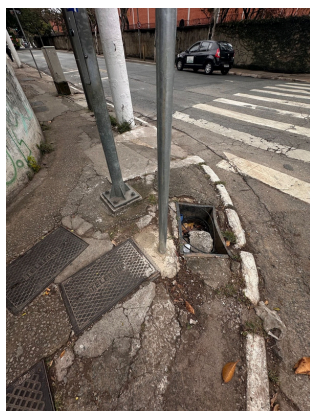
Imagem 24 - Desnível entre rampa e faixa de travessia
