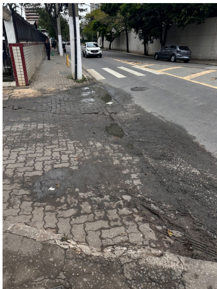
Imagem 31 - Vazamento de esgoto sobre calçada
