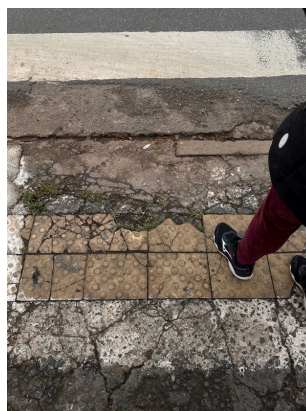
Imagem 25 - Piso tátil danificado na rampa de acesso
