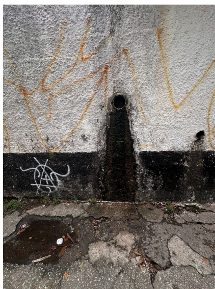
Imagem 35 - Saída de água sobre o nível da calçada
