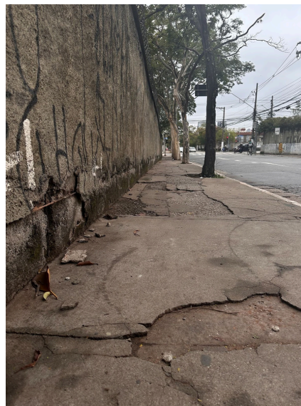
Imagem 18 - Fissuras e buracos em piso de concreto
