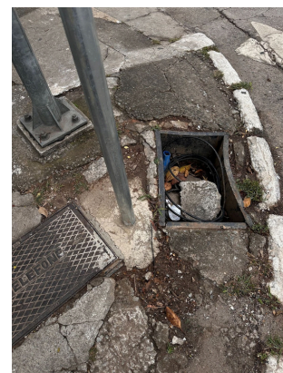
Imagem 26 - Caixa de passagem aberta junto à travessia
