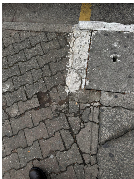
Imagem 08 - Piso em concreto com rachaduras
