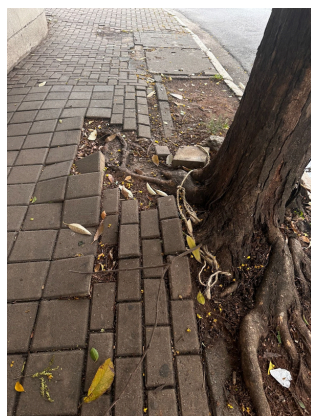
Imagem 28 - Alinhamento de árvores na faixa de serviço/ Deformação do pavimento
