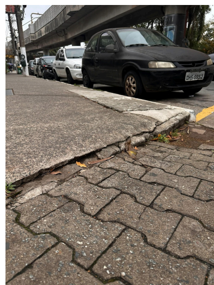
Imagem 07 - Piso intertravado com desníveis
