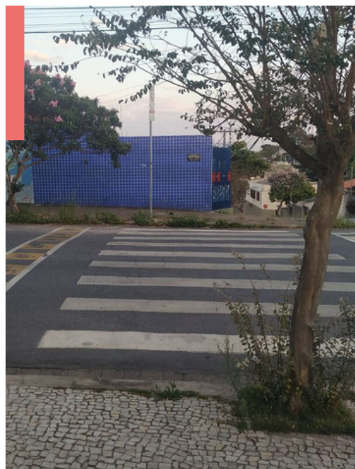
Rampa de acessibilidade inexistente Belo Horizonte-MG
