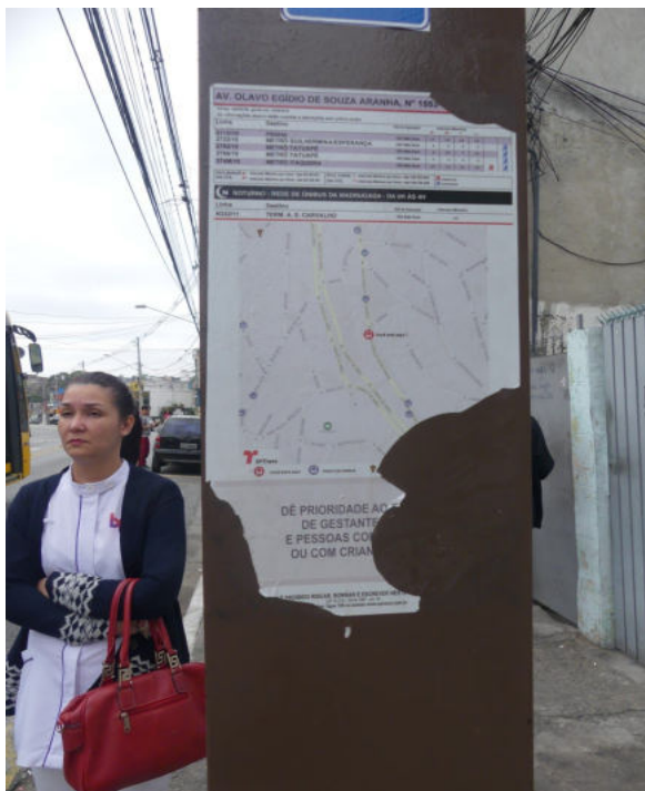
Foto 13: Ponto de ônibus sem abrigo e locais para sentar, além de sinalização danificada.
